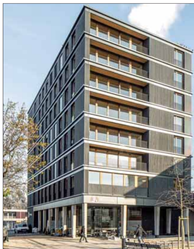
Bislang einmalig ist die Holztafelbauweise – kombiniert mit Brettsperrholz für Treppenhäuser und Aufzugschacht – in Gebäudeklasse 5. Das „Buggi 52“ wartet dafür mit vielen neuen Details auf, vor allen beim Brandschutz. Fotos: J. Weissenrieder
