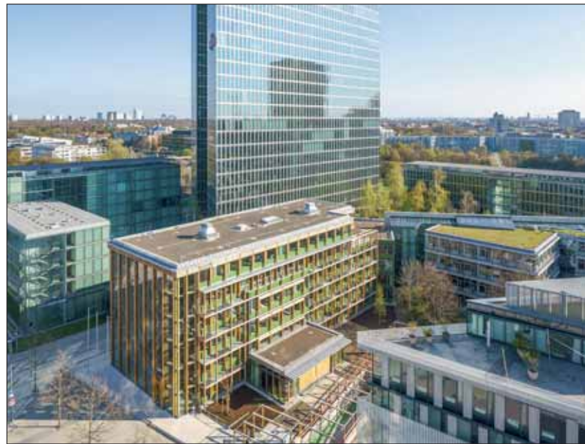
Im Münchner Stadtteil Schwabing ließ der Alpenverein einen Betonbau aus den 1970er-Jahren aufstocken und mit einer neuen Pfosten-Riegel-Fassade versehen – ein Vorbild für energetische Ertüchtigung zahlreicher Gebäude dieser Art aus den 1960er- bis 1980er-Jahren. Fotos: S. Schels
